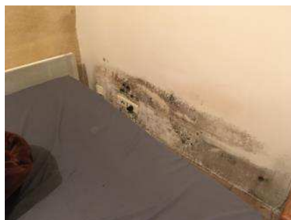
Moisissures dues à une ventilation obstruée par l'occupante et un encombrement de la chambre
