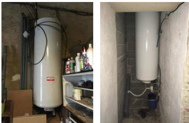
Chauffe-eau situé dans une grange attenante ou dans un garage non chauffé
