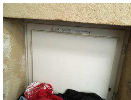
Moisissures dues à une ventilation obstruée par l'occupante et un encombrement de la chambre
